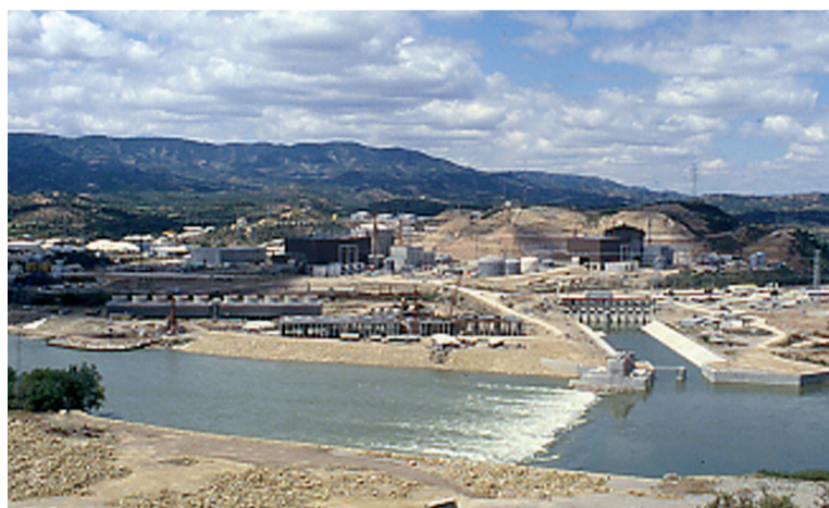
LA CENTRAL NUCLEAR D'ASCÓ DURANT EL PERÍODE DE LA SEVA CONSTRUCCIÓ.
