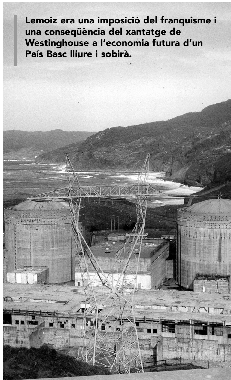
LES ESTRUCTURES DE FORMIGÓ DE LA CENTRAL DE LEMOIZ ABANDONADES I LES LÍNIES D'ALTA TENSIO QUE IBERDUERO VA DEIXAR INSTAL·LADDES DESPRÉS DEL TANCAMENT DEFINITIU. UNA IMATGE FANTASMAGÒRICA OCUPA ENCARA —AMB EL SILENCI DELS NACIONALISTES I ELS ABERTZALES— LA MERAVELLOSA CALA DE BASORDAS.
